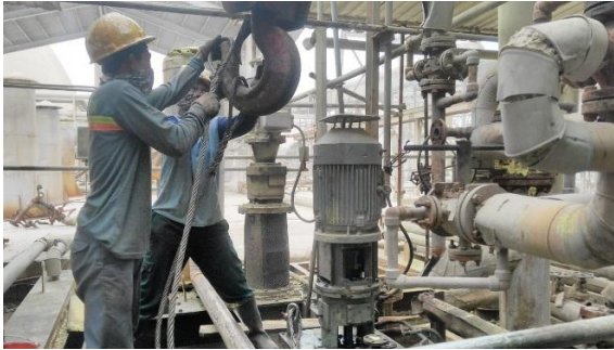
Gambar 4.2 Kegiatan Pengangkatan Sistem Pompa P-1002A/B
