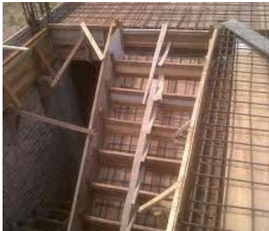
Gambar 5.14 Bekisting Tangga
