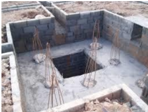
Gambar 5.11 Bekisting Batako Pilecap
