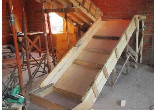
Gambar 5.14 Bekisting Tangga
