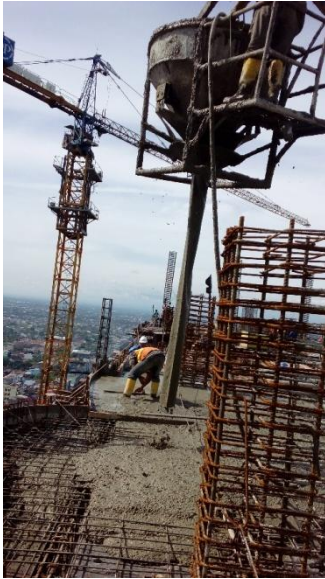
Gambar 10. 10 Pengecoran
