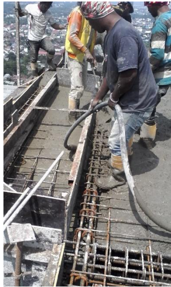
Gambar 10. 11 Pengecoran
