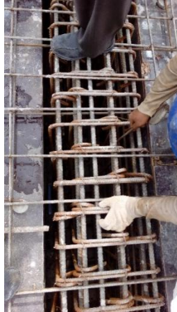
Gambar 10. 8 Pengecekan Tulangan Balok
