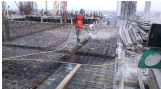
Gambar 10. 9 Pembersihan Lokasi Pengecoran
