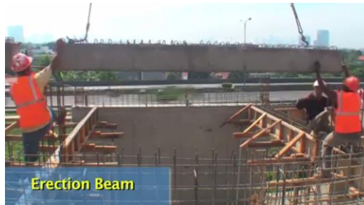
Gambar 9.16 Pemasangan balok pracetak
