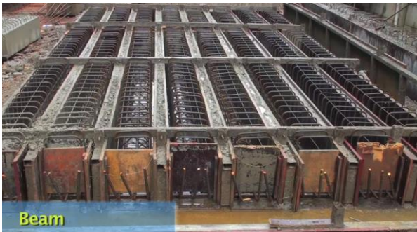
Gambar 9.11 Fabrikasi balok pracetak
