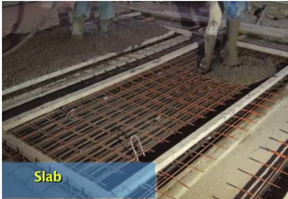
Gambar 9.10 Fabrikasi pelat pracetak (Sumber : Video pelaksanaan pembangunan Rusunawa Rempoa)
