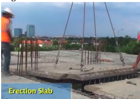
Gambar 9.15 Pemasangan pelat pracetak
