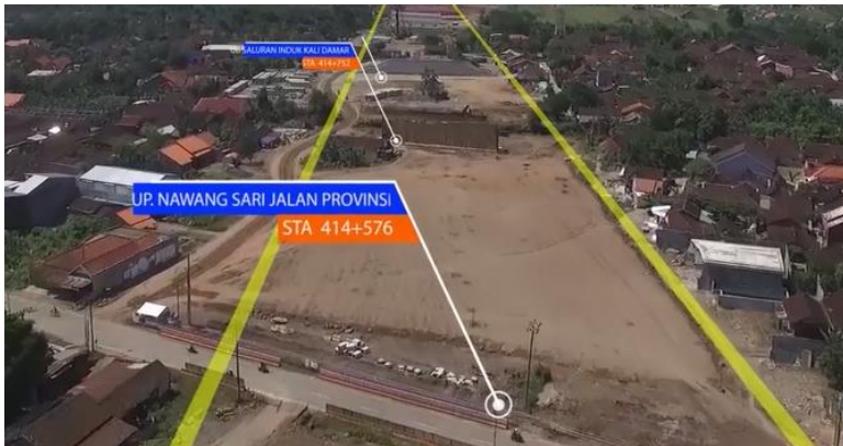
Gambar 1. 1 Lokasi studi kasus jalan tol Batang Semarang Seksi 3 STA 414+600 s/d STA 414+725
