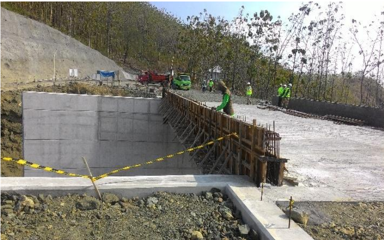
Gambar 6. Pengecoran Pada Jembatan
