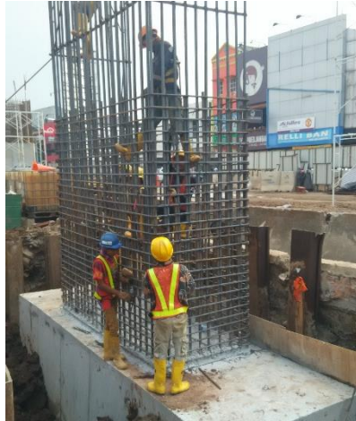
Gambar 5. 7 Penulangan Pilar
