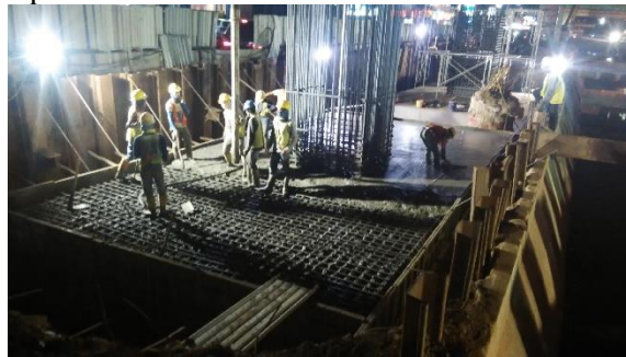
Gambar 5. 6 Pengecoran Pilecap
