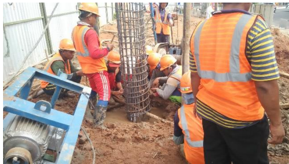
Gambar 5. 2 Pembesian Boredpile
