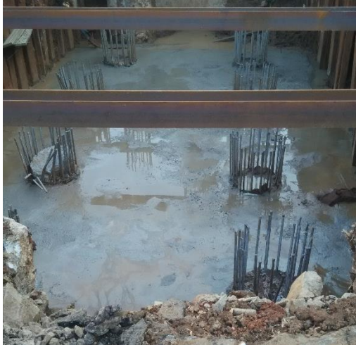
Gambar 5. 4 Lantai kerja pada pilecap
