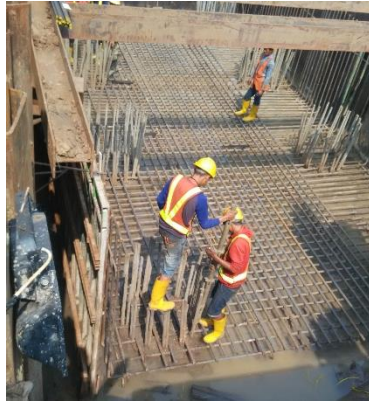
Gambar 5. 5 Pembesian Pilecap
