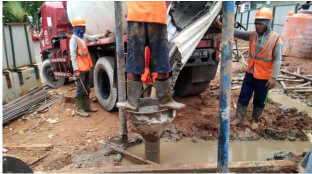
Gambar 5. 3 Pengecoran Boredpile
