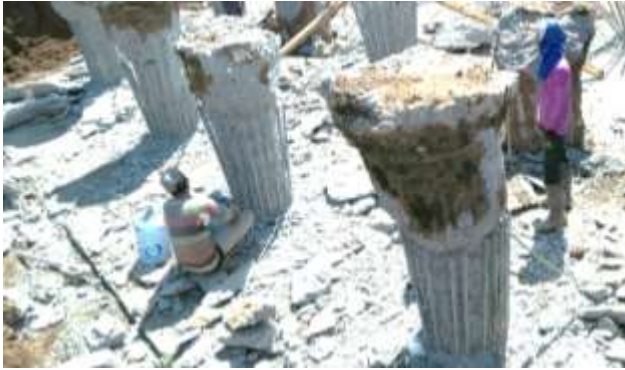
Gambar 6. 1 Pemotongan kepala bor pile
