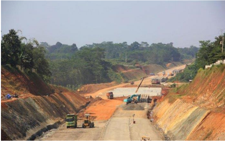
Gambar 1.3 Pembangunan Tol Semarang-Batang di Kecamatan Tulis
