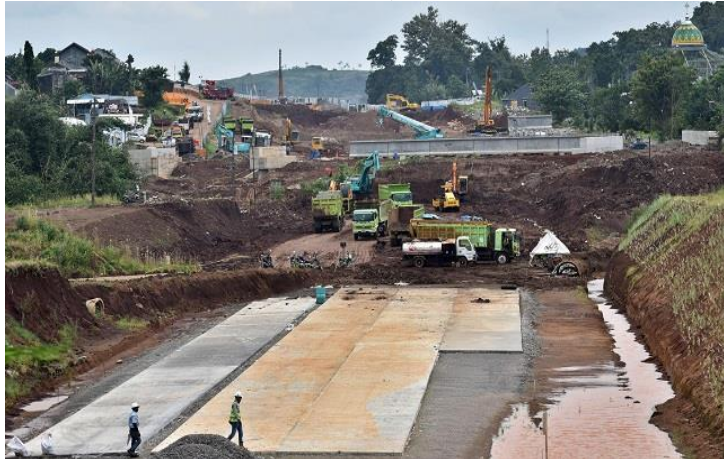
Gambar 1.4 Pembangunan Tol Semarang-Batang di Ngaliyan, Semarang
