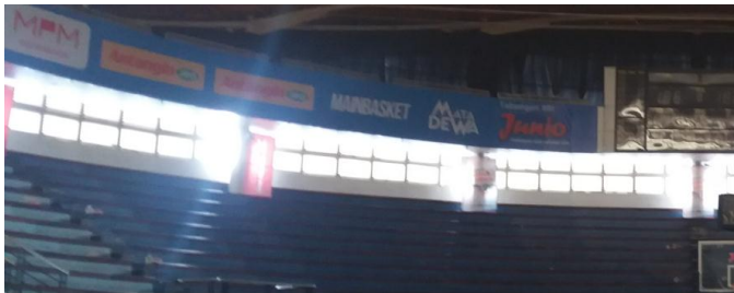
Gambar 4. 4 Ventilasi Gedung DBL Arena
