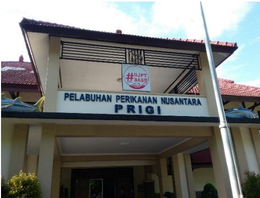
Kantor Pelabuhan Perikanan Nusantara Prigi (PPN)
