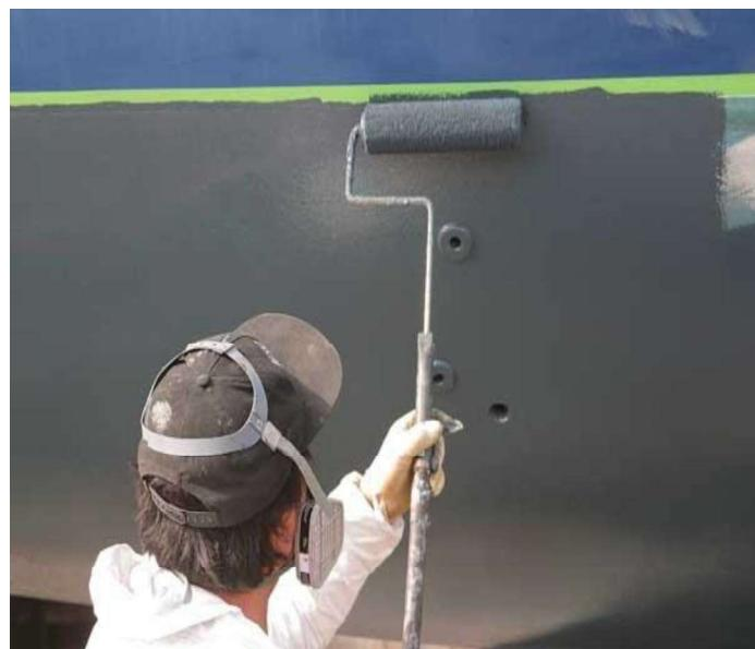
Gambar 2.3 Pengecatan dengan *Roller*
