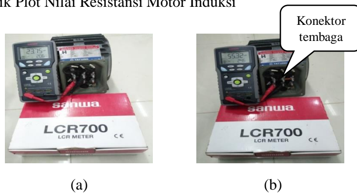
Gambar 4.8 (a) Pengujian Nilai Resistansi dan Induktansi Perphase (b) Pengujian Nilai Resistansi dan Induktansi Antar Phase
