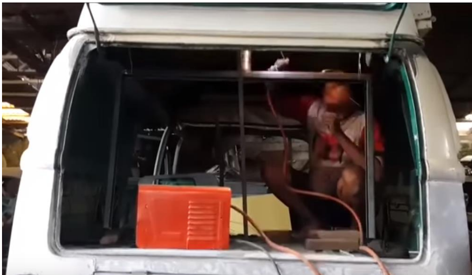
Gambar IV. 26 Pemasangan atap tambahan pada kabin platform (2) (Dokumen Pribadi)
