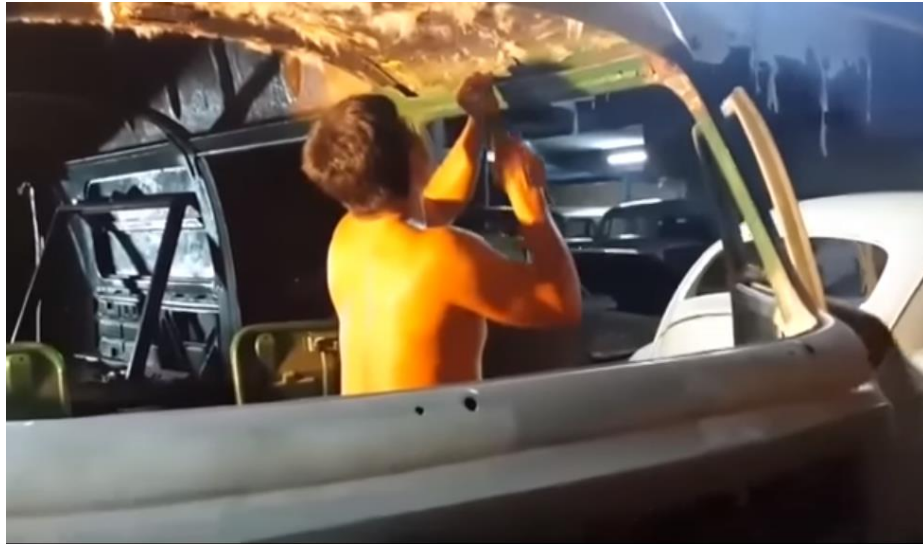
Gambar IV. 25 Pemasangan atap tambahan pada kabin platform (Dokumen Pribadi)
