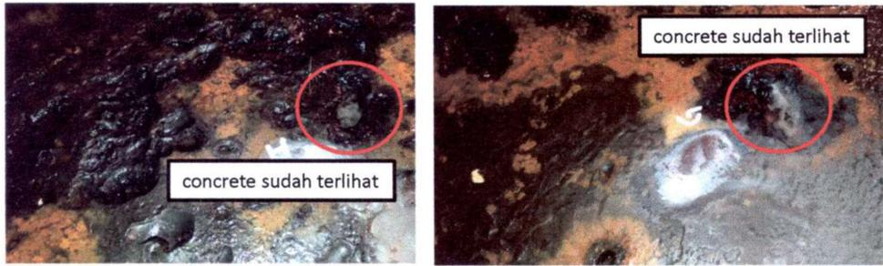
Gambar 4.38 Kondisi *erosion* pada *draft tube* unit 3
