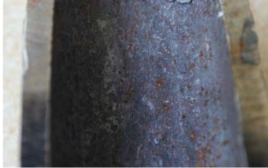
Gambar 4.16 Produk korosi Fe-H 2 O yang berwarna merah-kecoklatan
