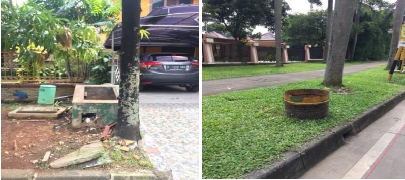
Gambar 4. 21 Bak sampah kecil yang disediakan oleh PT Jababeka di lingkungan kawasan permukiman komersial di Kawasan Industri Jababeka Sumber: Survei primer, 2018
