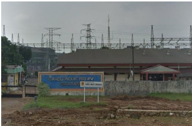
Gambar 4. 19 Pembangkit Listrik Untuk Area Perumahan dan Komersial di Kawasan Industri Jababeka Cikarang Sumber: Survei primer, 2018
