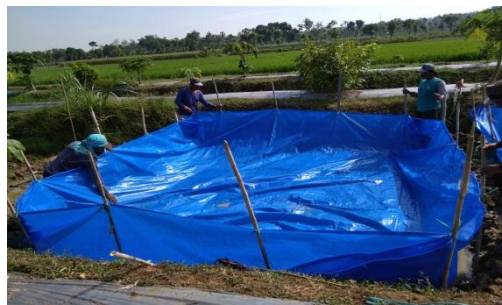
Pemasangan terpal pada kolam
