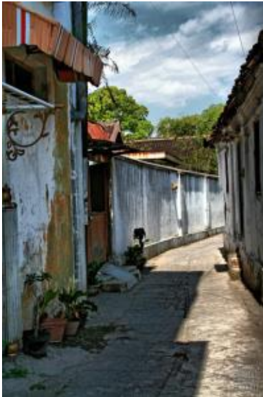
Gambar 4. 1 Bangunan dengan Tembok Tinggi
