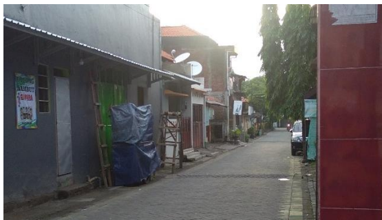
Gambar 4. 13 Kondisi Lapangan Kelompok Zona AG
