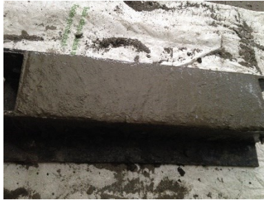
Gambar 3. 21 Pemerataan permukaan cetakan
