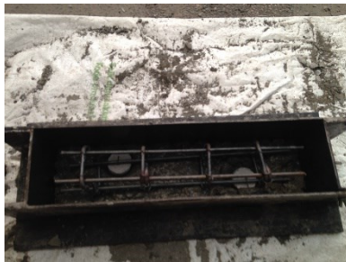
Gambar 3. 20 Campuran dimasukkan ke dalam bekisting
