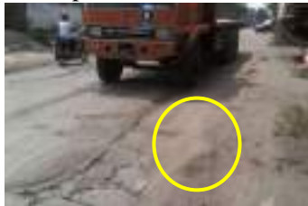
Gambar 1.2 Perkerasan Bergelombang
