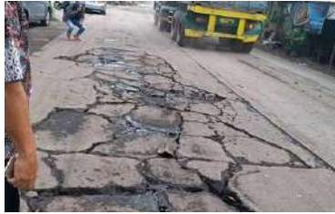
Gambar 1.4 Perkerasan Retak Sumber: http://goo.gl/images/juUUz1 . Diakses tanggal 20 September 2018.
