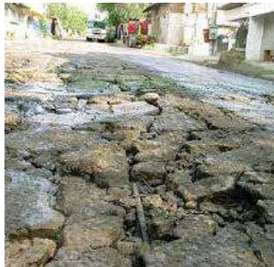
Gambar 1.5 Tulangan yang Muncul ke Permukaan Sumber: http://goo.gl/images/ujvG4E . Diakses tanggal 20 September 2018.
