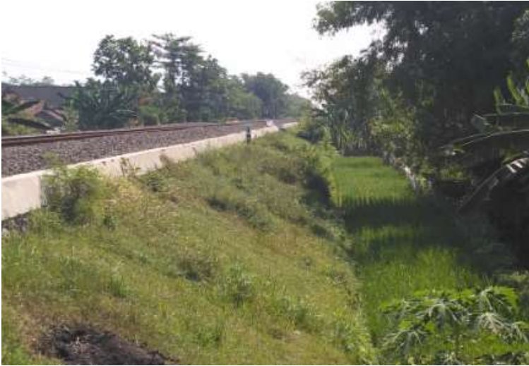
Gambar 4. 13. Pengamatan Langsung Pada STA 203 +900
