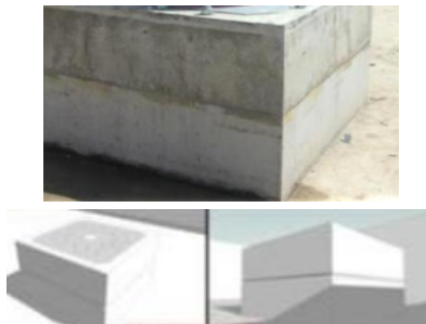
Gambar 98. Kolom Pedestal dan base plate yang Telah Selesai di Cor (Suardi, 2013)
