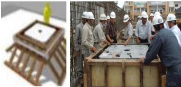
Gambar 96. Pemasangan Bekisting untuk Pengecoran Tahap 2 (Suardi, 2013)
