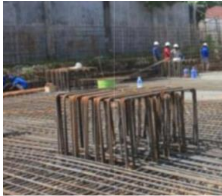
Gambar 91. Pembesian Kolom Pedestal (Suardi, 2013)
