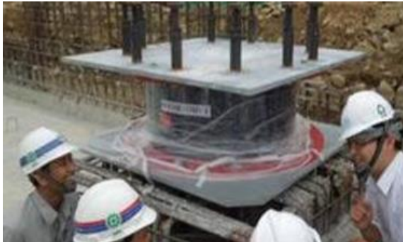
Gambar 101. Pemasangan Baut pada Top Plate (Suardi, 2013)
