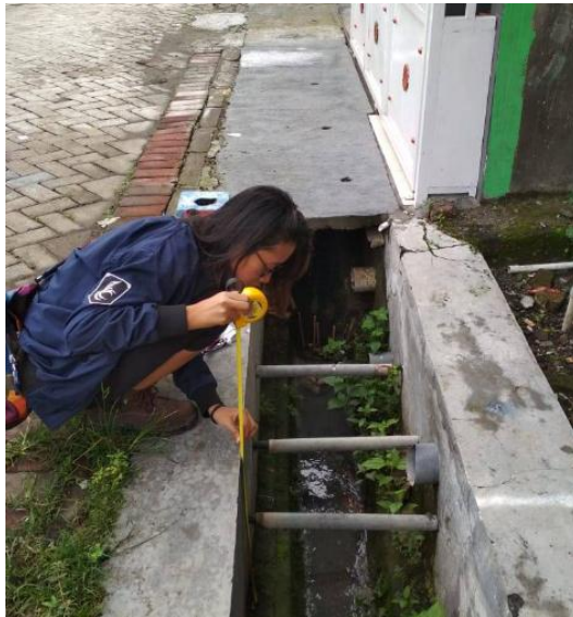
Lampiran 3. Pengukuran tinggi saluran eksisting hilir waduk
