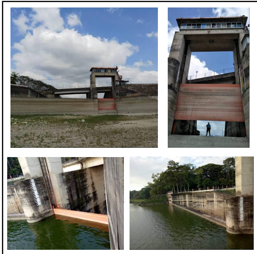
Gambar 2.16 Dinding Pelimpah dan Pintu Spillway Waduk Sutami (PJT1, 2018)
