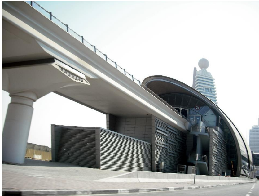
Gambar 2. 28 Stasiun Dubai Metro
