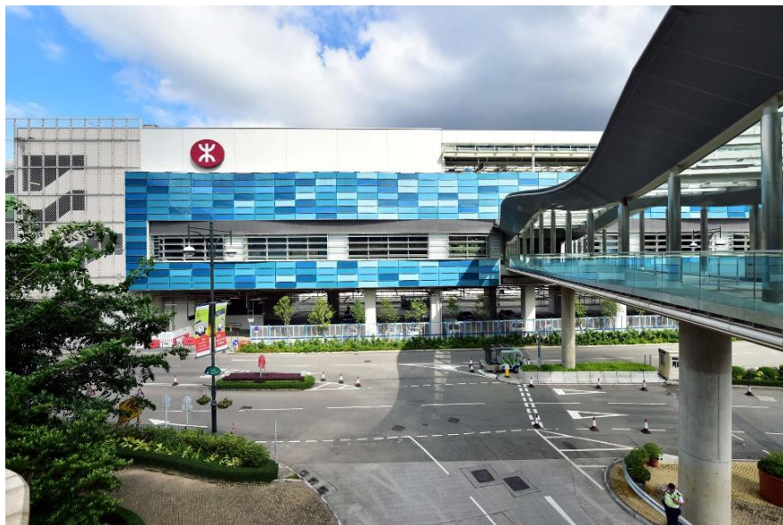
Gambar 2. 30 Stasiun MTR Hongkong
