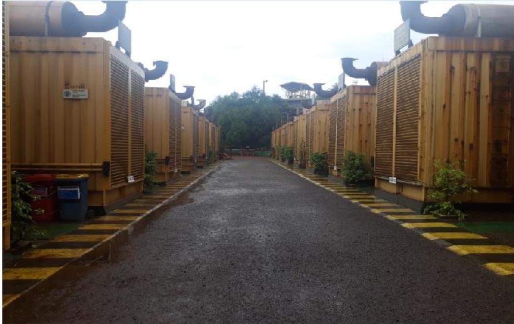
Gambar 3. 3 Pembangkit Listrik Tenaga Diesel CAT Diesel Engine Plant
