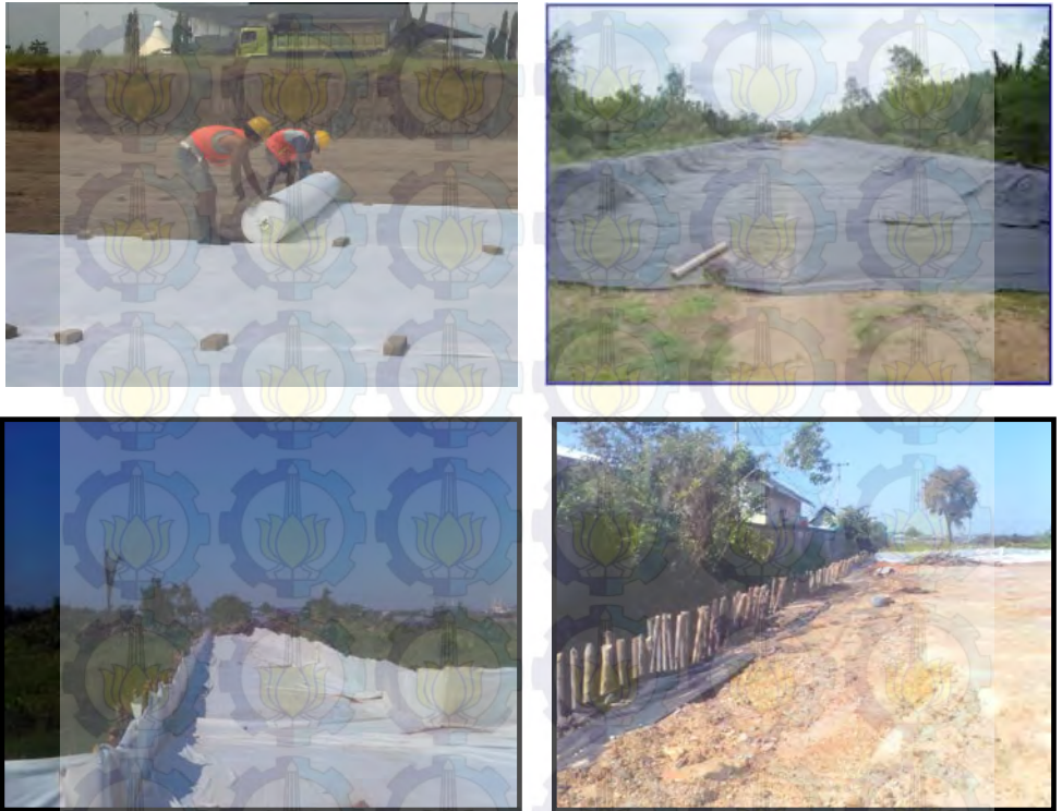
Gambar 4.12 Pekerjaan Geotextile
