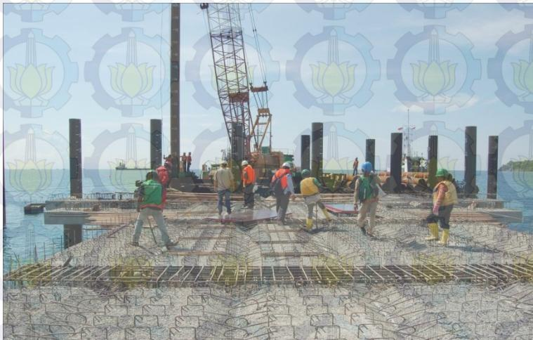
Gambar 2.10. *Half slab precast* pada proyek dermaga
