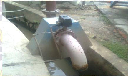
Gambar Pipa Pembuangan Lumpur
