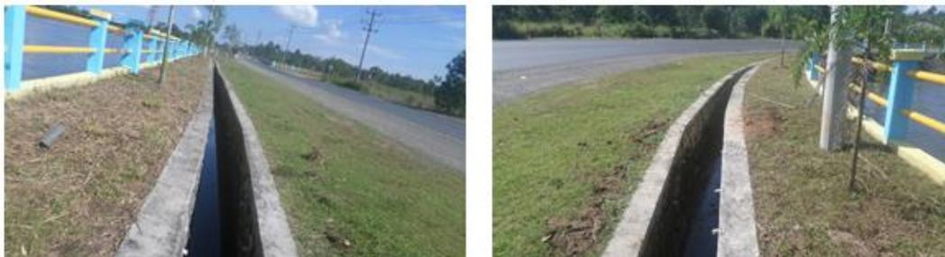
Gambar 4.10: Gambar Saluran Drainase Keliling Embung Sei Gesek
