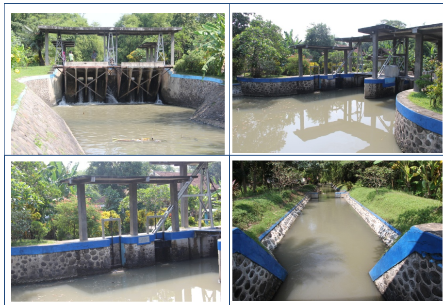
Gambar 4.11 Bangunan pada DI. Subantoro
