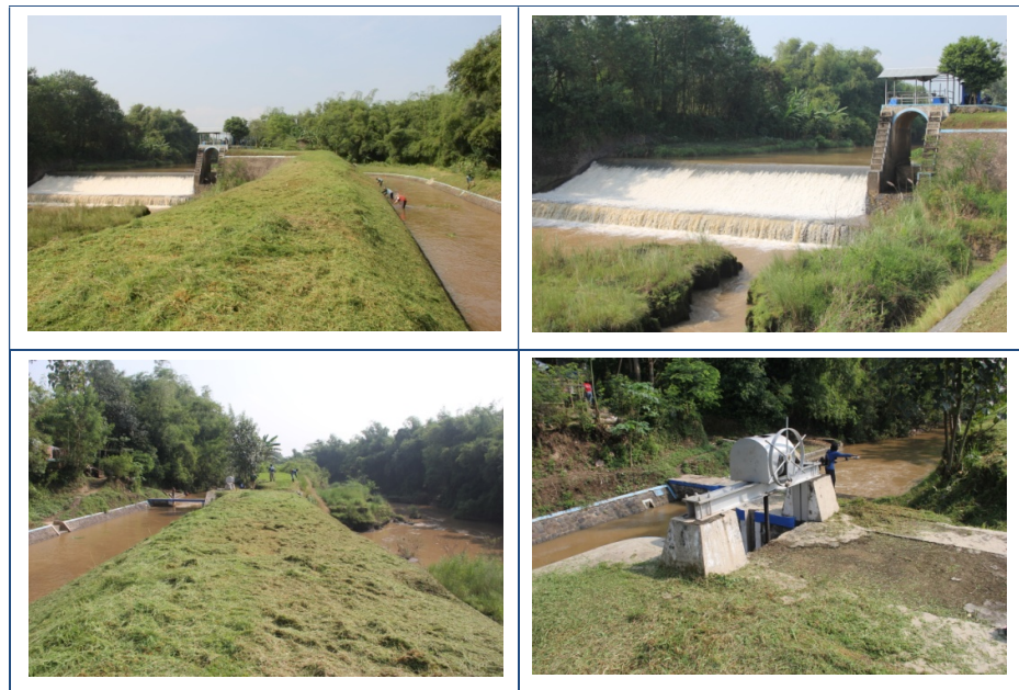
Gambar 4.5 Bangunan pada DI. Penewon
