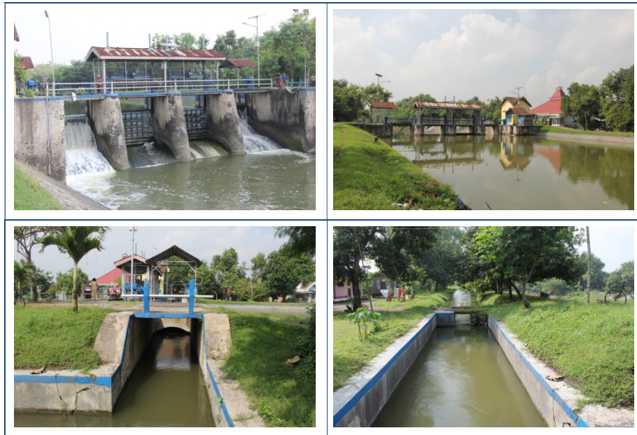
Gambar 4.7 Bangunan pada DI. Penewon
