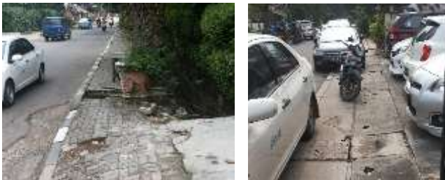
Gambar. 4.31 dan 4.32 Kondisi Pedestian Pada Blok 6 Sumber: Dokumentasi Pribadi, 2016
