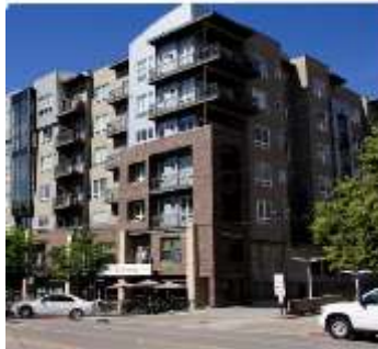
Gambar. 4.49 Flat House di Kota Utah, USA
