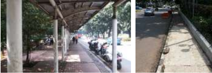
Gambar. 4.27 dan 4.28 Kondisi Pedestian Pada Blok 4 Sumber: Dokumentasi Pribadi, 2016
