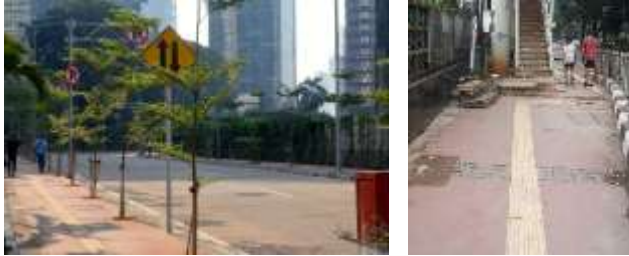
Gambar. 4.33 dan 4.34 Kondisi Pedestian Pada Blok 7 Sumber: Dokumentasi Pribadi, 2016
