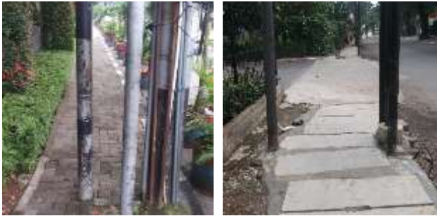
Gambar. 4.29 dan 4.30 Kondisi Pedestian Pada Blok 5 Sumber: Dokumentasi Pribadi, 2016
