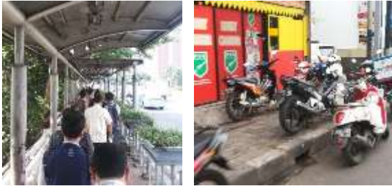
Gambar. 4.23 dan 4.24 Kondisi Pedestrian Pada Blok 2 Sumber: Dokumentasi Pribadi, 2016
