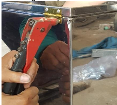
Gambar 4.4 Proses pemasangan paku keling
