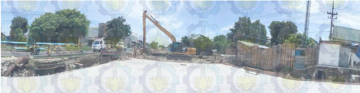
Pembangunan Box Culvert di Saluran Gunungsari pada Persimpangan Kali Balong
