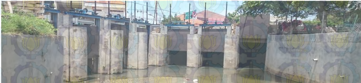
Bangunan Pembagi pada Kali Simo
