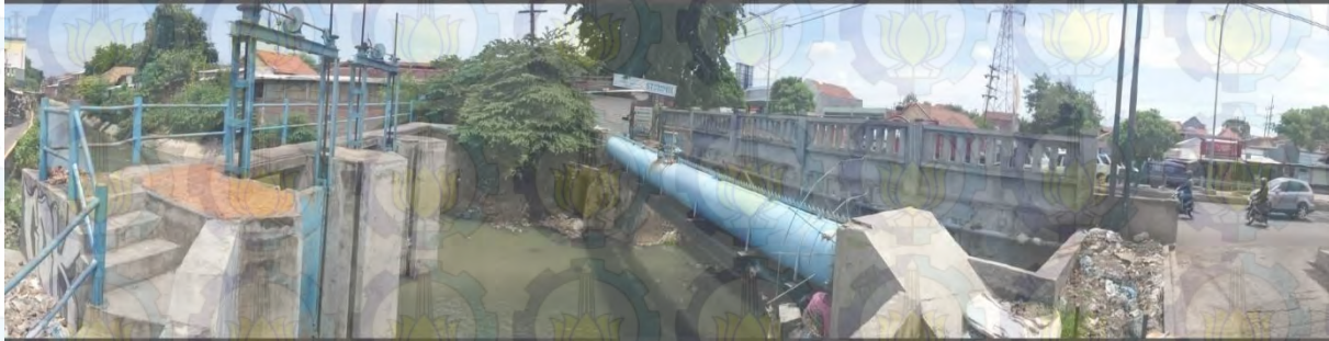
Pintu Air di Kali Simo (sesudah Jembatan)
