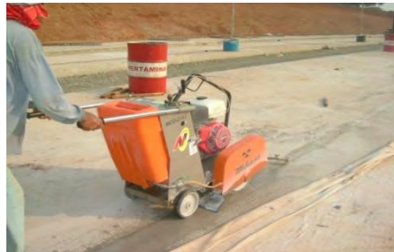
Gambar 4.32 Penggergajian Beton
