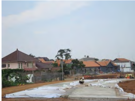
Gambar 4.23 Pemasangan Geotextile
