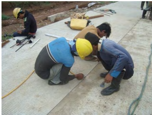
Gambar 4.33 Pembersihan Celah Sambungan
