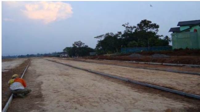
Gambar 4.20 Pemasangan Bekisting
