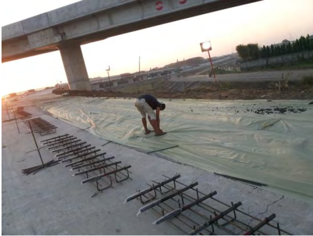
Gambar 4.27 Persiapan Pengecoran
