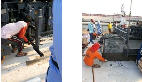
Gambar 4.30 Pemasangan Tiebar pada Paver
