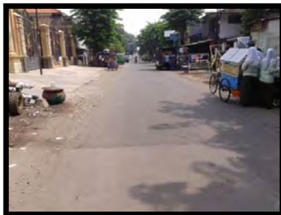
Gambar 3.3 Kondisi Jalan Wilayah Perencanaan di Kelurahan Simolawang
