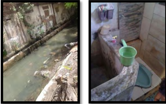
Gambar 3.6 Kondisi saluran drainase dan salah satu contoh kondisi kamar mandi di wilayah perencanaan Kelurahan Tambakrejo
