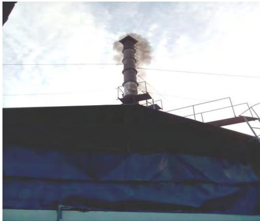
Gambar 5.28 Asap Hitam Keluar dari Cerobong Insinerator
