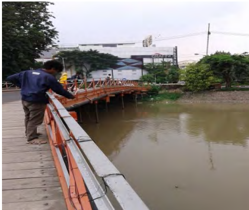
Gambar A.5 Kondisi Air Sungai Pada Segmen 1-2 (Jembatan Peneleh)
