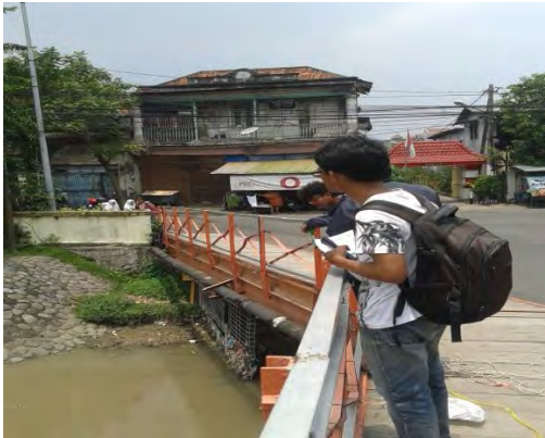
Gambar A.4 Kondisi Air Sungai Pada Segmen A-1 (Jembatan Jalan Genteng Kali)
