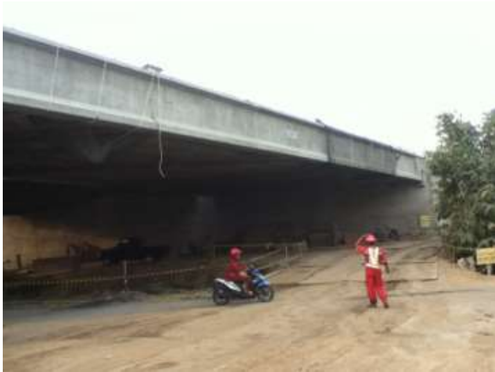
Gambar 1. 3 Kondisi eksisting jembatan sumberwaru
