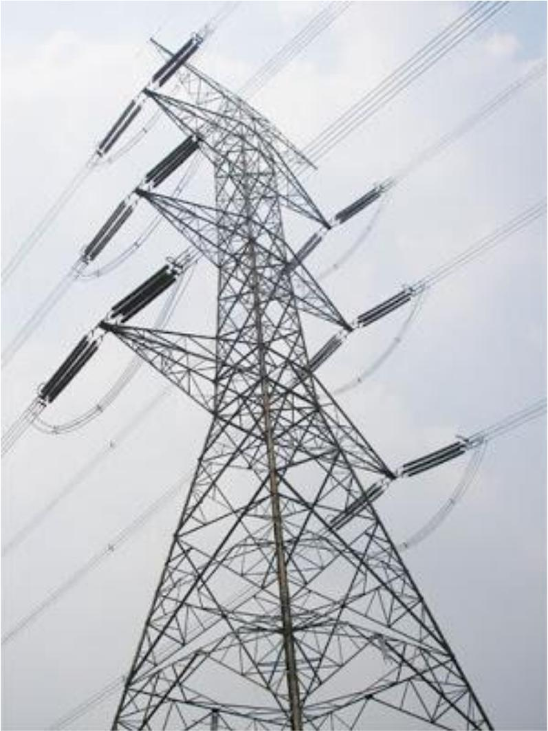
Menara Tension Saluran Transmisi 500 kV
