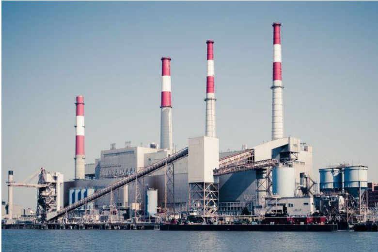
Gambar 2.1 Pembangkit Listrik Tenaga uap
