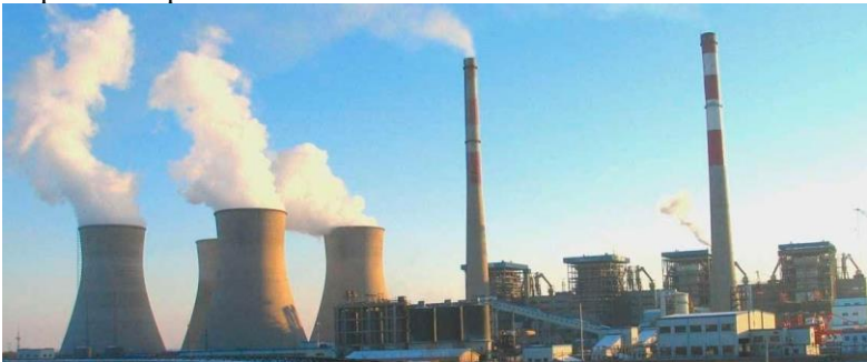
Gambar 2.1 Pembangkit Listrik Tenaga Uap
