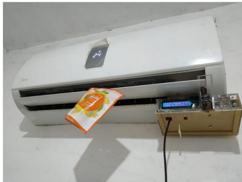
Gambar 4.14. Alat yang sudah terpasang pada pendingin ruangan
