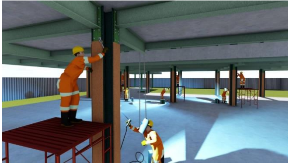
Gambar 7. 7 Pekerjaan perkuatan kolom dan sambungan
