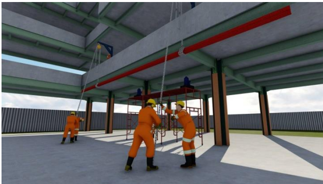
Gambar 7. 10 persiapan proses erection dengan menggunakan chain block
