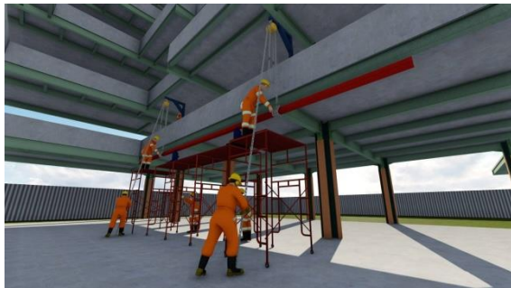
Gambar 7. 14 Ilustrasi pelepasan rantai chain block dari profil perkuatan
