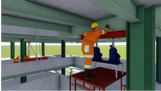
Gambar 7. 19 Pemasangan perkuatan balok kantilever lantai 4-7
