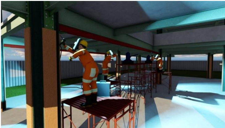
Gambar 7. 17 Proses pengelasan profil perkuatan terhadap profil eksisting
