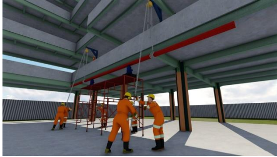
Gambar 7. 13 Ilustrasi peletakkan balok perkuat diatas jack hidraulik
