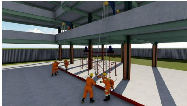
Gambar 7. 12 Proses erection profil perkuatan.
