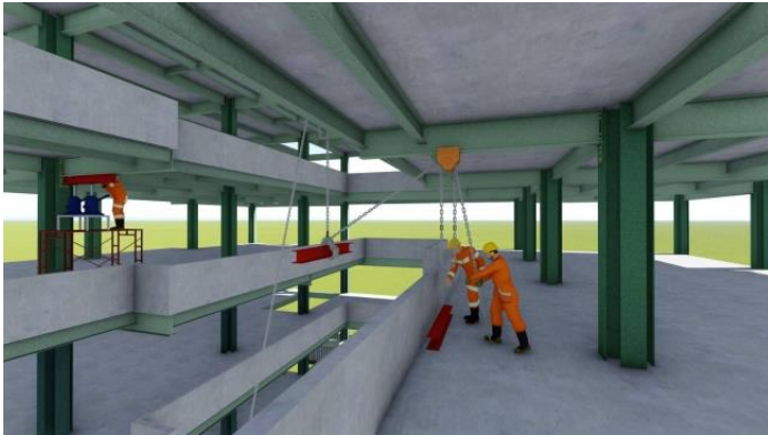
Gambar 7. 18 Proses erection pada balok kantilever lantai 4-7 dan 8-10.
