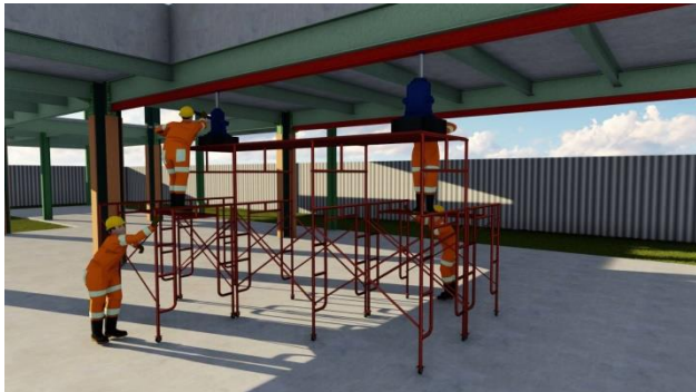
Gambar 7. 16 Ilustrasi pendongkrakan perkuatan pada profil eksisting
