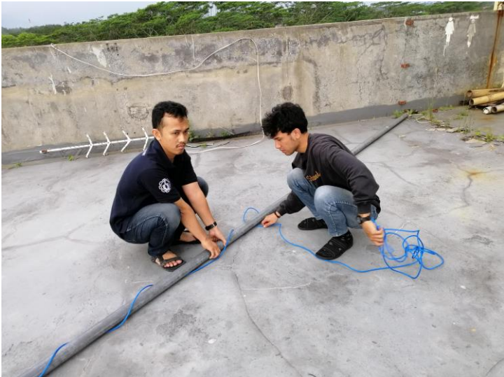
Gambar 4.3 Proses pemasangan antena penerima
