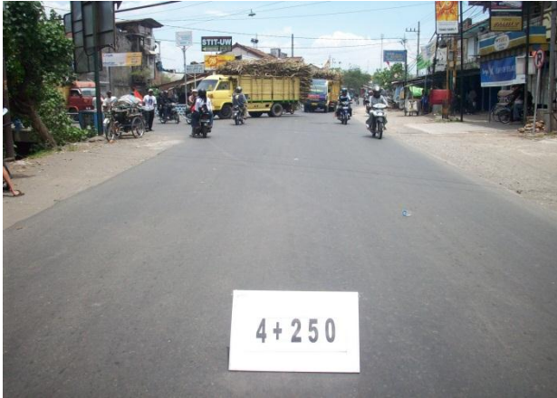
Gambar 1.6 Ruas Jalan pada STA 4 + 250
