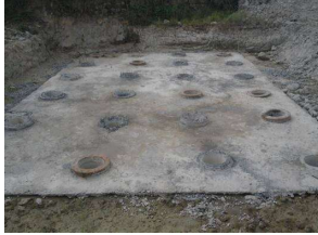
Gambar 4. 8 Contoh pembuatan lantai kerja
