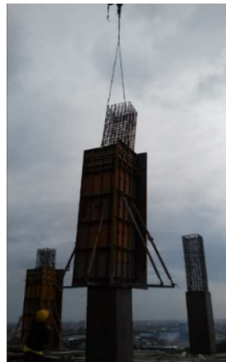
Gambar 4. 35 Pembongkaran Bekisting Kolom
