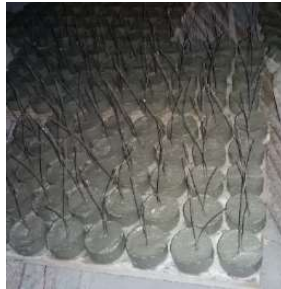
Gambar 4. 32 Pemasangan Beton decking
