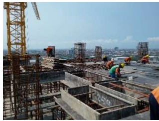
Gambar 4. 22 Pembuatan Bekisting Balok
