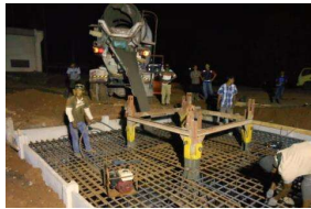
Gambar 4. 12 Contoh pekerjaan pengecoran base tower crane
