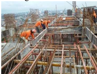
Gambar 4. 22 Pembuatan Bekisting Balok
