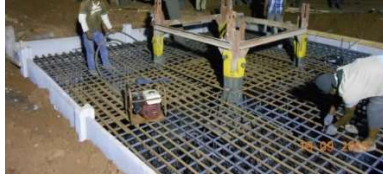
Gambar 4. 11 Contoh pengerjaan pembesian tower crane
