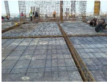
Gambar 4. 26 Perakitan Tulangan Bawah pada Pelat
