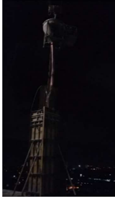
Gambar 4. 34 Penuangan Beton pada Kolom
