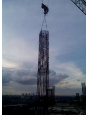
Gambar 4. 31 Pengangkatan Tulangan Kolom
