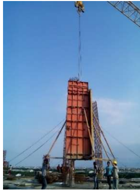
Gambar 4. 33 Pemasangan Bekisting
