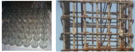
Gambar 4. 38 Pemasangan Beton Decking
