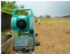
Sumber : Dokumen Pribadi Gambar 4. 17 Marking Area TC
