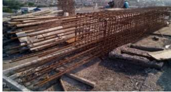
Sumber : Dokumen Pribadi Gambar 4. 34 Tulangan Kolom
