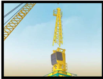
Gambar 4. 27 Pemasangan Cat Head
