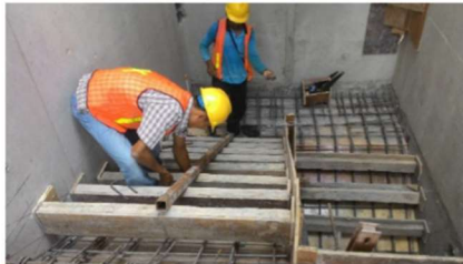
Gambar 4. 57 Pemasangan Tulangan Tangga
