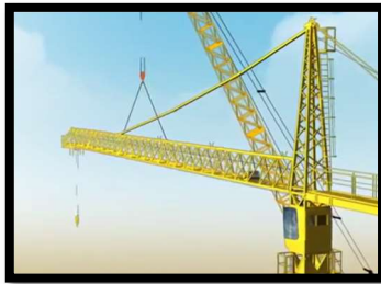
Gambar 4. 29 Pemasangan Jib atau Boom
