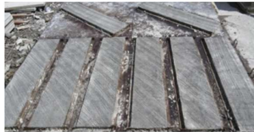
Sumber : Dokumen Pribadi Gambar 4. 59 Pengecoran Top Cover Tangga
