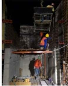
Sumber : Dokumen Pribadi Gambar 4. 58 Pengecoran Tangga
