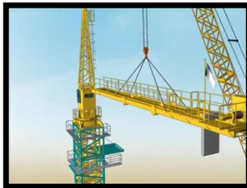
Gambar 4. 28 Pemasangan Counter Jib
