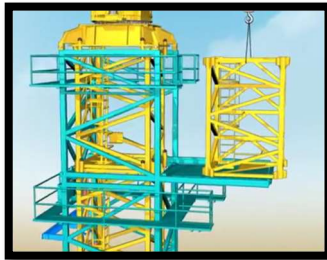
Gambar 4. 30 Pemasangan Mass Section Penambahan
