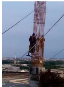
Gambar 4. 37 Penyambungan Tulangan Kolom
